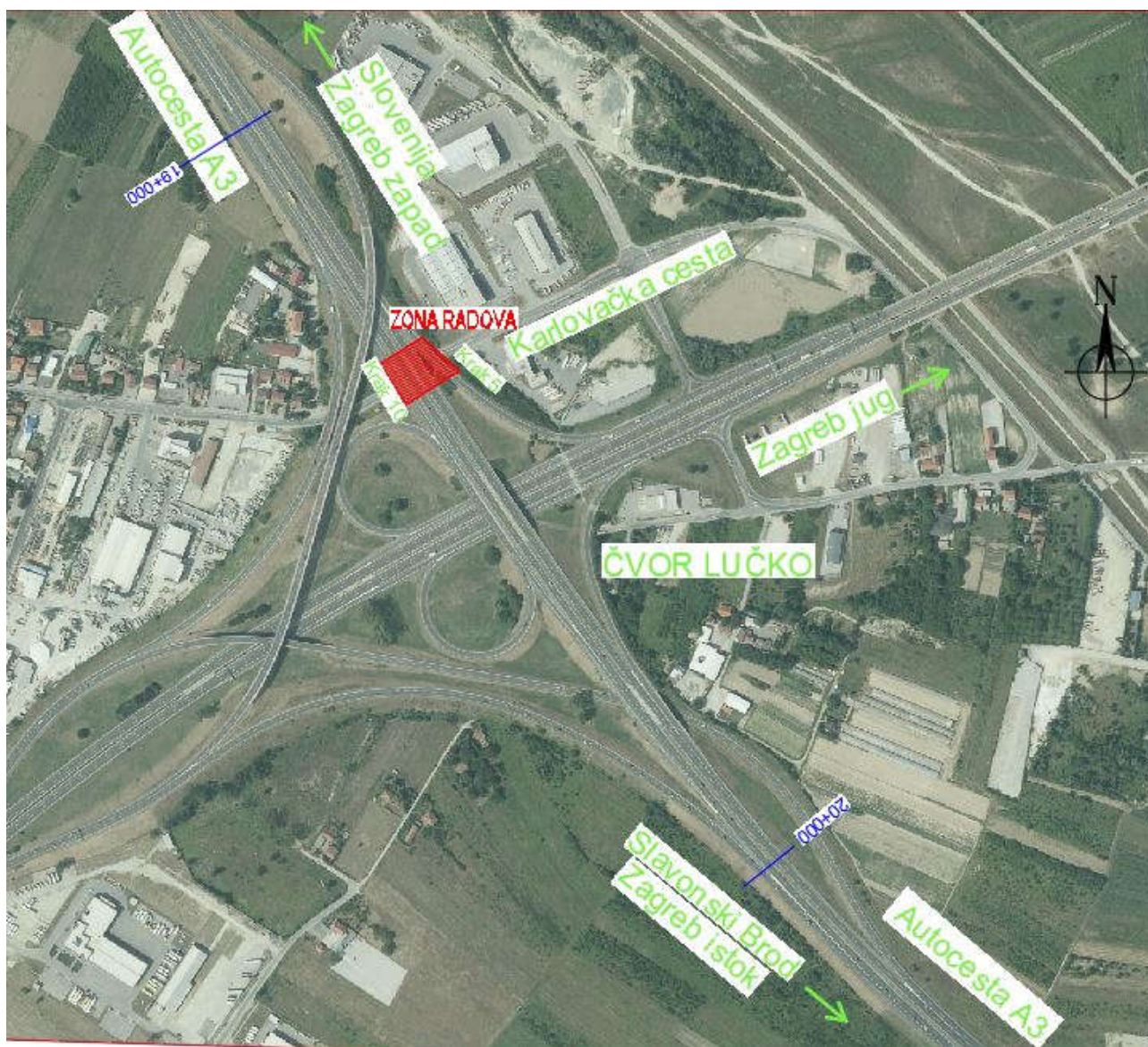
Slika 1. Podvožnjak Karlovačka u km 19+326 (izvor: Geoportal DGU)
