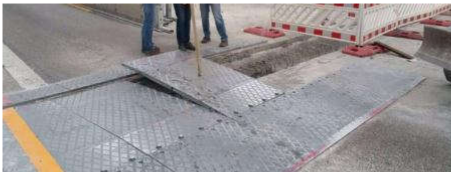
Slika 2. Primjer izvedbe privremenog mobilnog sustava za osiguranje prometa preko zone radova (nadsvođenje korita u kojem se ugrađuje nova prijelazna naprava)
