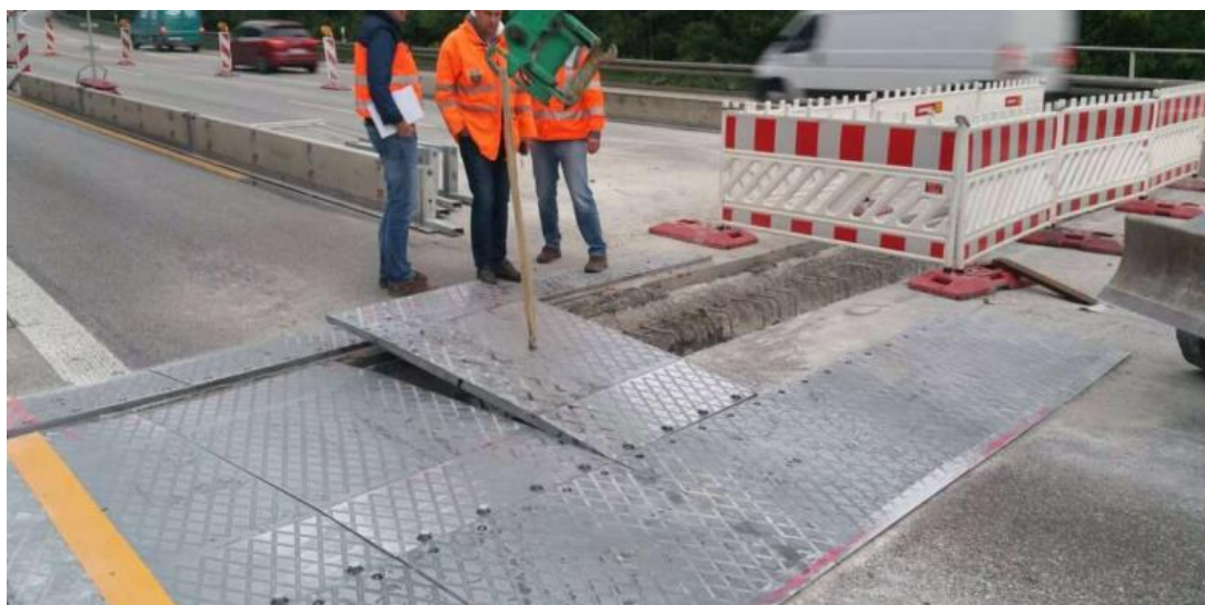
Foto 1: primjer izvedbe privremenog prijelaznog sustava za nadsvođenje korita u kojem se ugrađuje nova prijelazna naprava.
