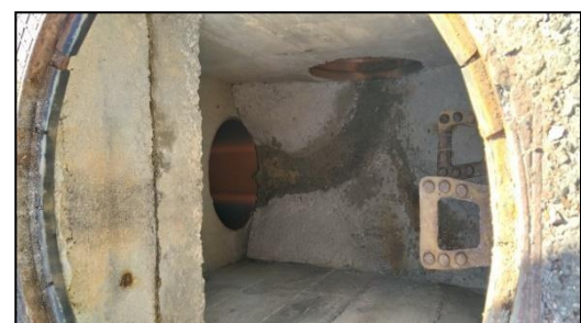
Slika 6. Unutrašnjost okna RO 27-D
