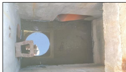
Slika 4. Unutrašnjost okna RO 26-D1
