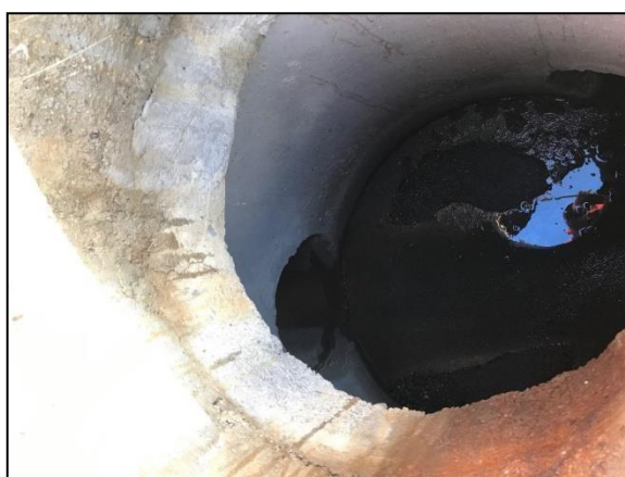
Slika 2. Unutrašnjost okna RO 24
