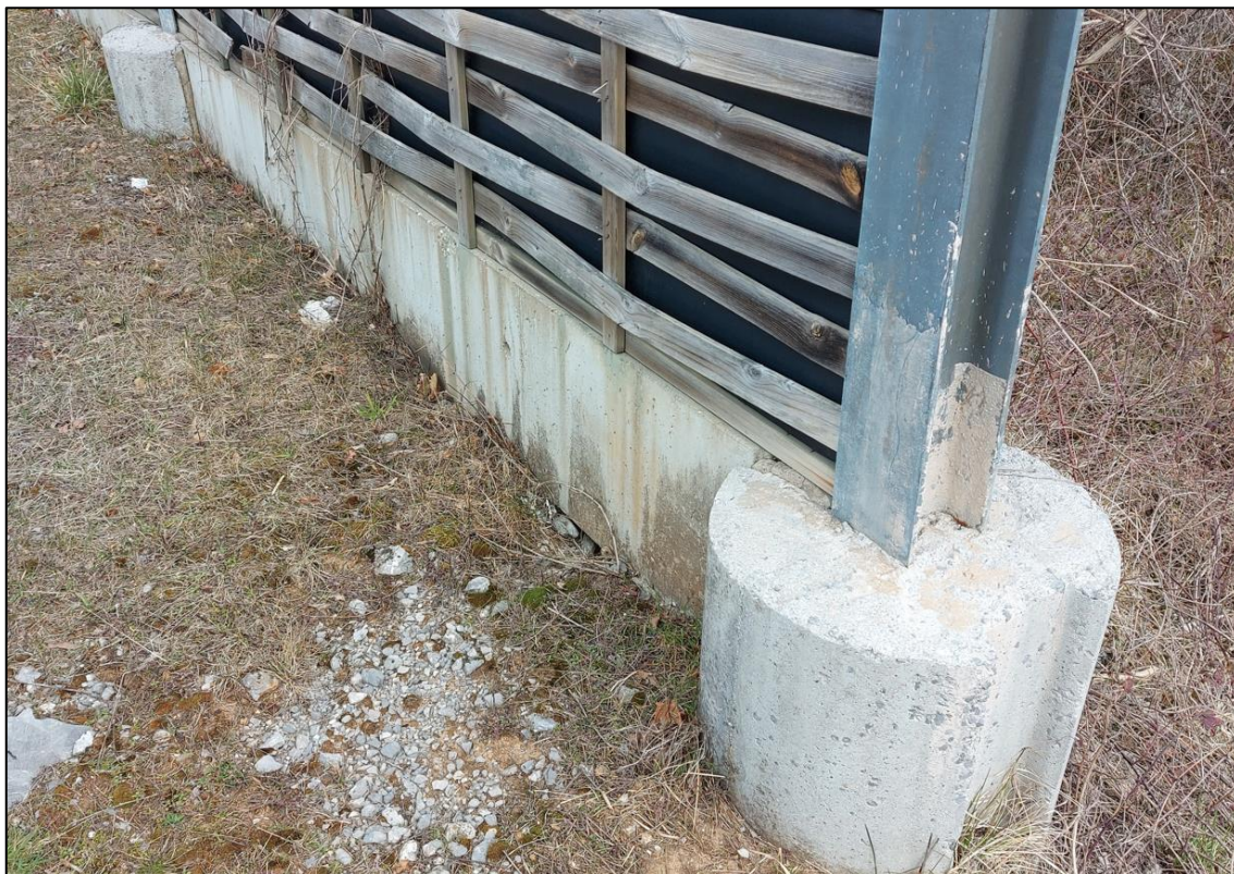
Slika 7. km 8+700.00 – okrugla glava pilota
