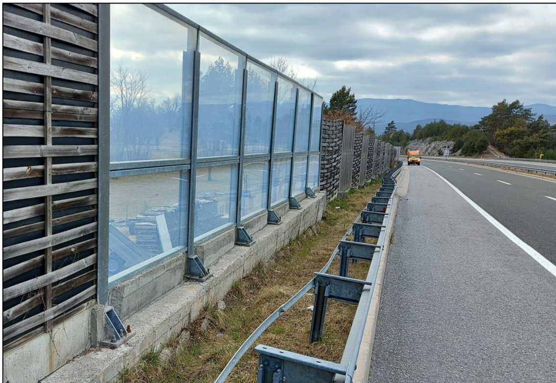
Slika 3. km 0+400.00 – transparentni paneli na nadvožnjaku
