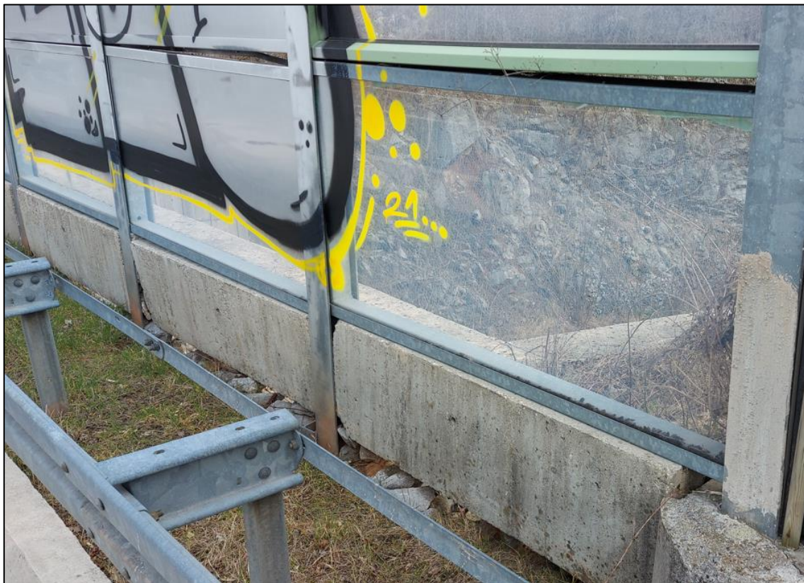
Slika 13. km 9+000.00 - 9+500.00 - stanje naglavnih greda i transparentnih panela na nadvožnjaku
