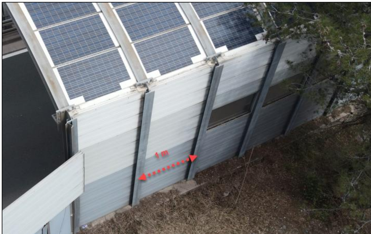
Slika 22. km 25+000.00 – osni razmak HEA profila na dijelu galerije
