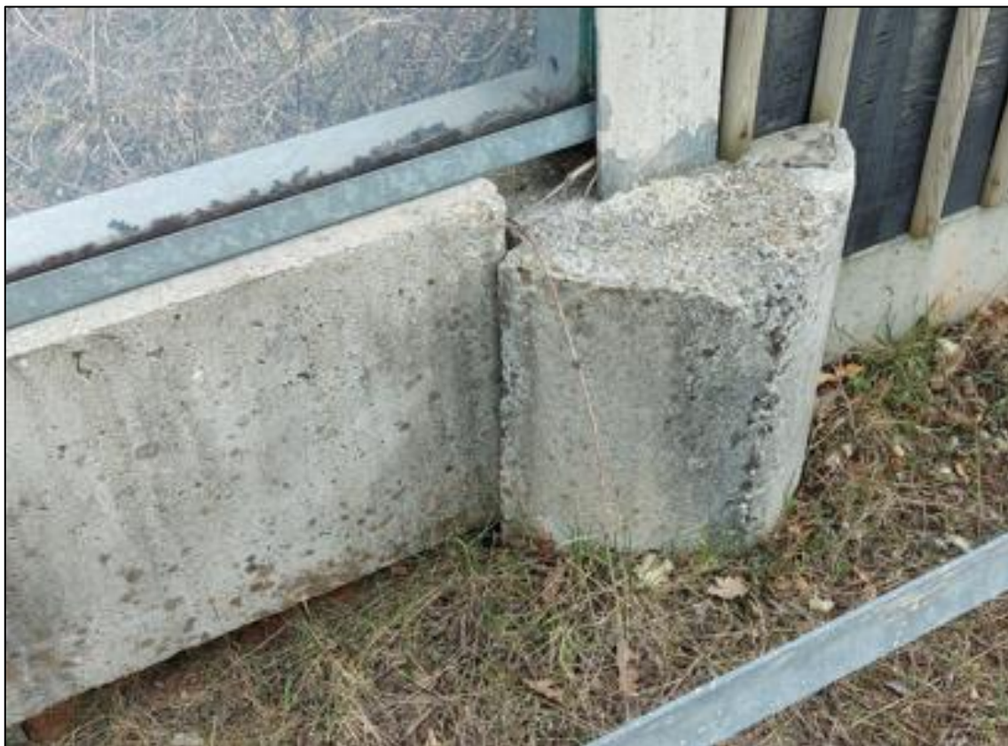
Slika 14. km 9+000.00 - 9+500.00 - odvajanje naglavnih greda i glava pilota
