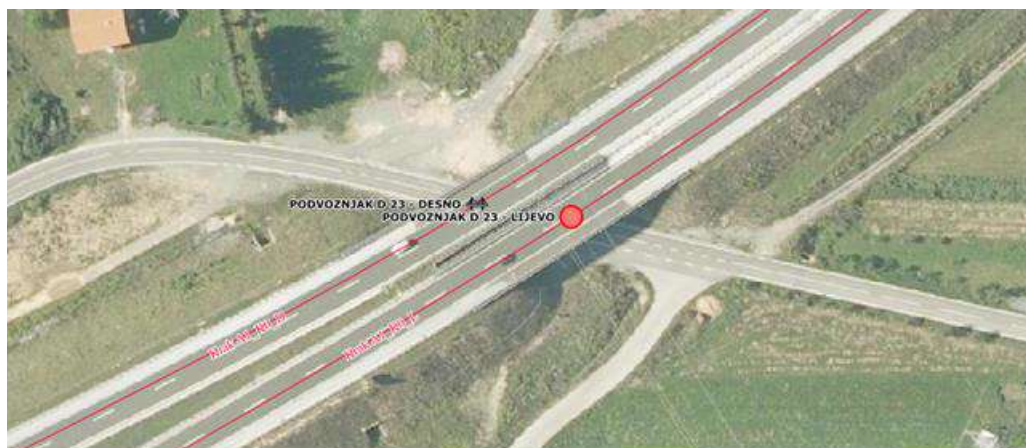
Slika 1_Podvožnjak D23 u km 121+400, autoceste A1 Zagreb – Split – Dubrovnik
