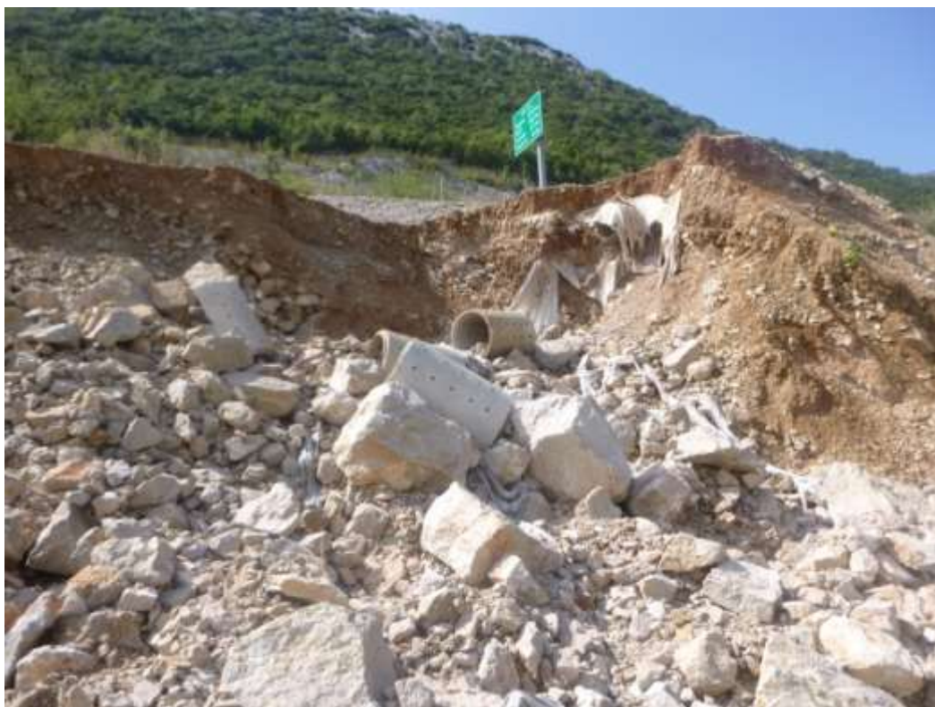
Slika 3 – Urušeni dio nasipa i infiltracijskog jarka
