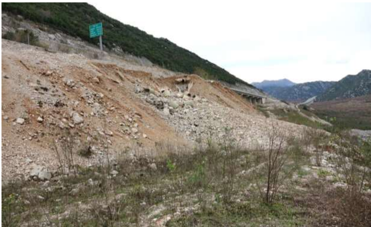
Slika 2 – Prikaz urušenog infiltracijskog jarka s odronom materijala na servisni (makadamski) put
