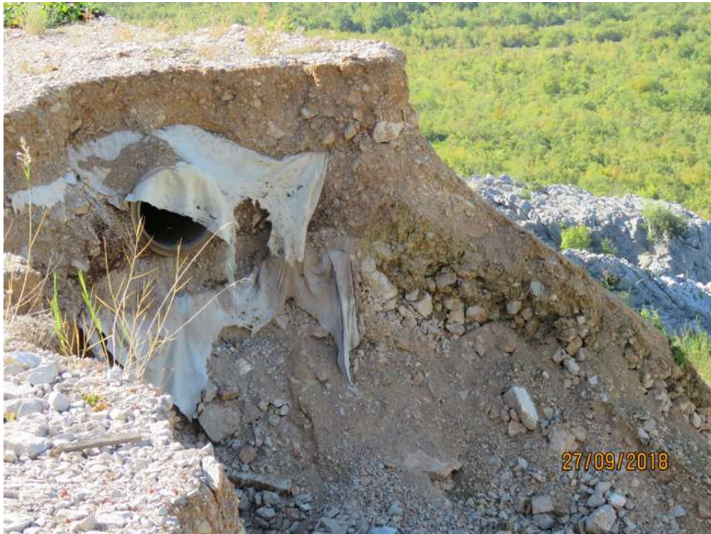
Slika 4 – Prikaz izvedenog nasipa i položene betonske cijevi infiltracijskog jarka
