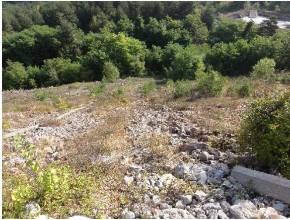
Pogled na eroziju nasipa izazvanu prelijevanjem vode s kolnika
