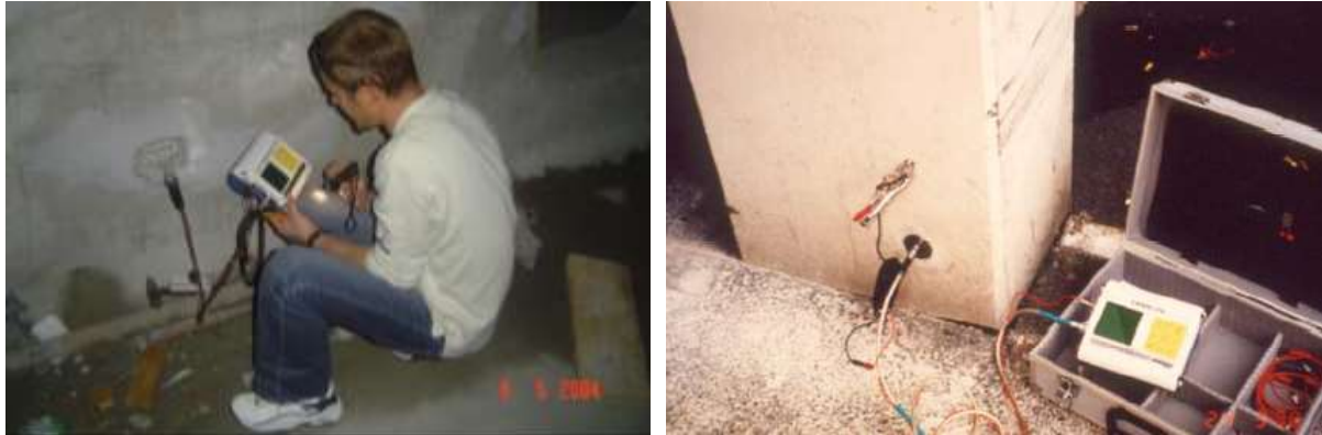
Slika 6. Mjerenje na konstrukciji
