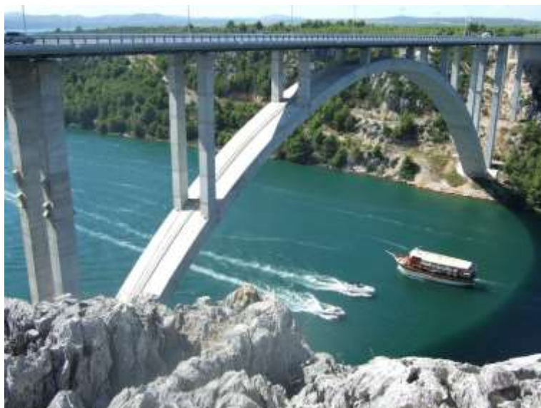
Slika 2. Pogled na rasponsku konstrukciju mosta Krka
