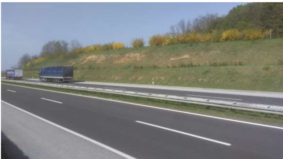
Slika 2. Desna strana usjeka od km 81+650 do km 81+900
