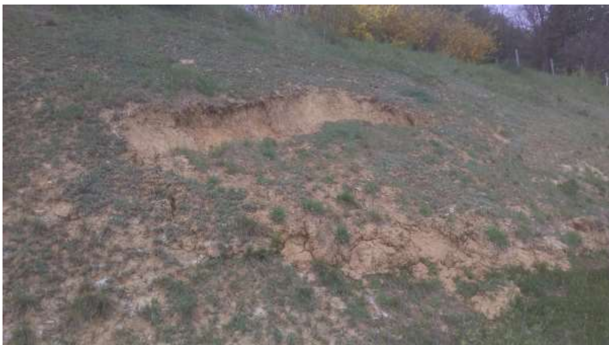
Slika 4. Primjer nestabilnosti na gornjoj etaži pokosa
