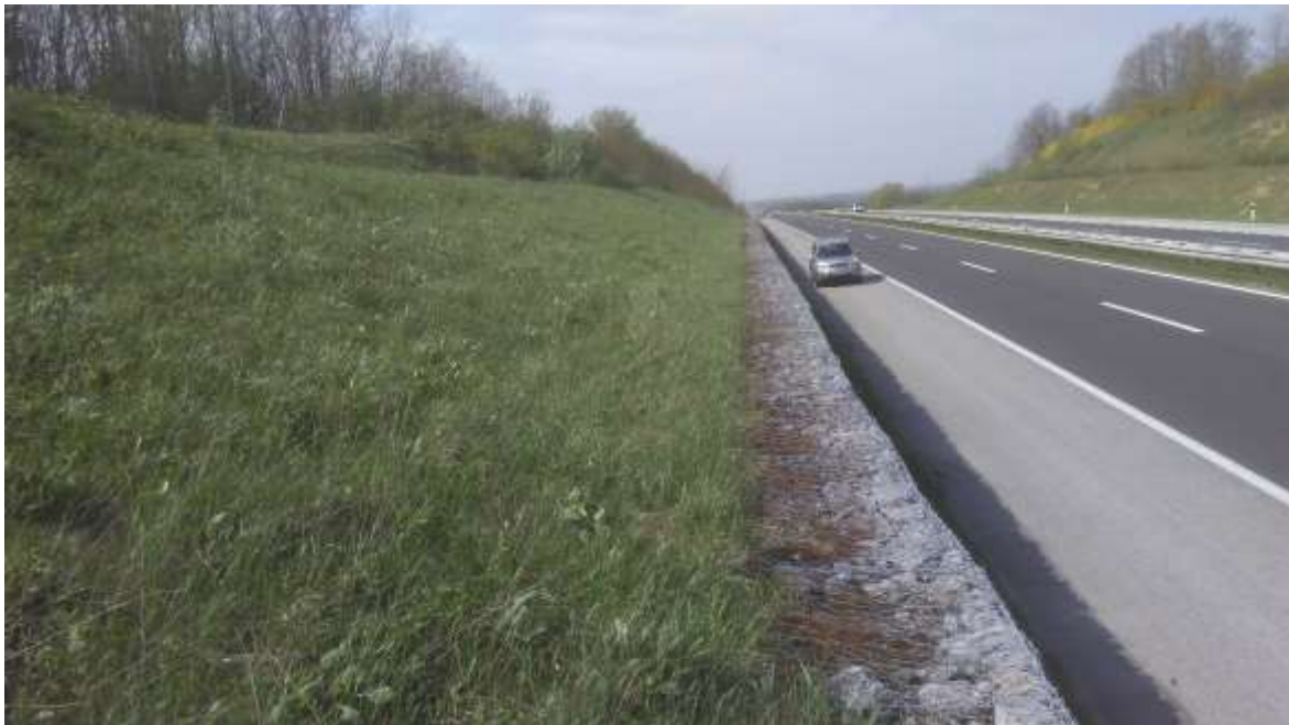
Slika 1. Lijeva strana usjeka stabilizirana gabionskom potpornom konstrukcijom
