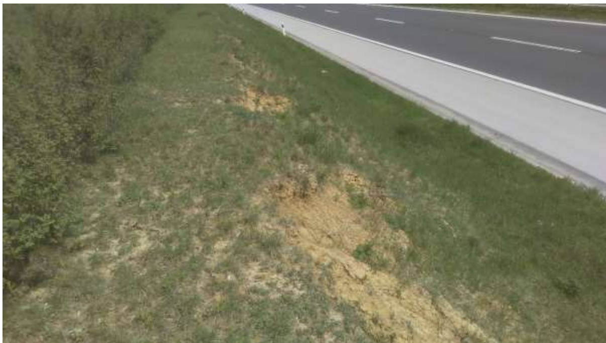
Slika 3. Primjer nestabilnosti na donjoj etaži pokosa i bermi
