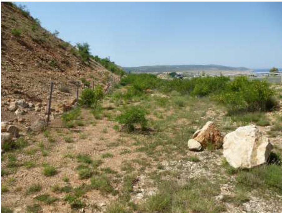
Slika 6. Blokovi koji su probili žičanu ogradu
