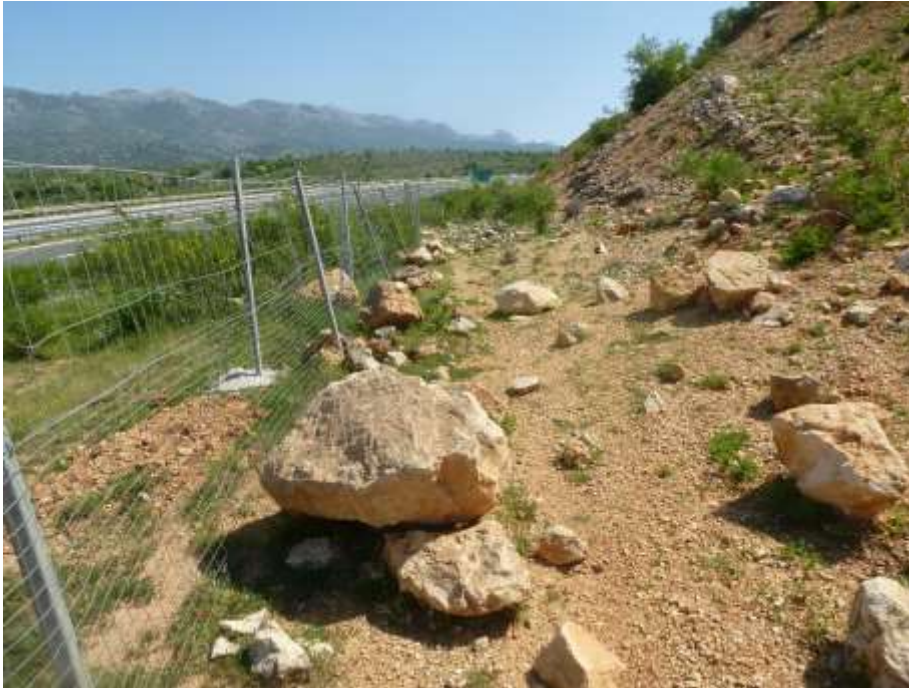
Slika 5. Odronjeni deponirani materijal u nožici pokosa deponije
