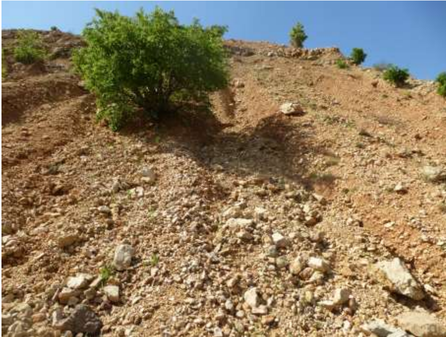
Slika 3. Erozijske brazde duž pokosa deponije
