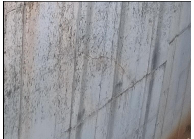
Slika 1.1-5 i 6: Izgled površine betona koji ukazuje na nehomogenu strukturu betona i očigledni veliki sadržaj primjesa u betonu
