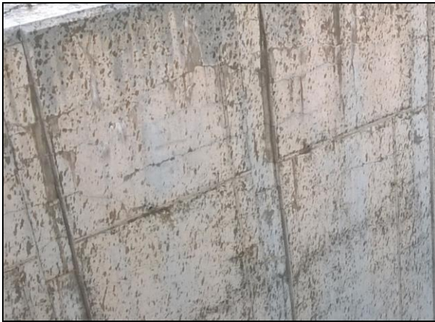
Slika 1.1-5 i 6: Izgled površine betona koji ukazuje na nehomogenu strukturu betona i očigledni veliki sadržaj primjesa u betonu
