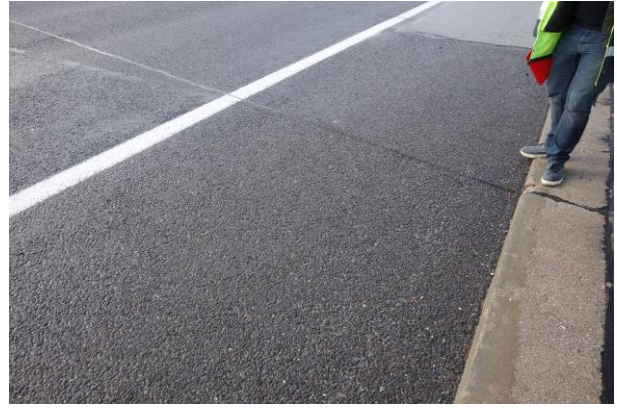
Slika 1.6 Pogled na dilataciju prema upornjaku bez prijelazne naprave
