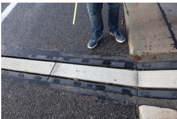
Slika 1.3 Detalj prijelazne naprave
