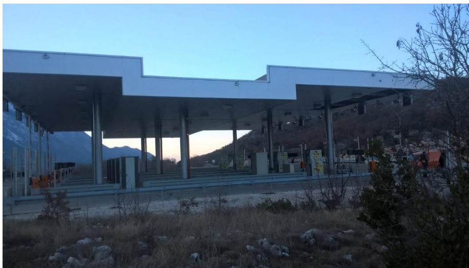
Slika 1. Pogled na nadstrešnicu
